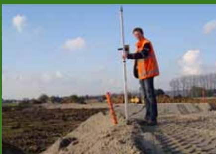
December 2008: het tracé wordt tot op de centimeter precies gemeten.
