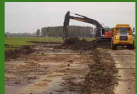
September-oktober 2008: graafmachines leggen zand neer, zodat de bodem alvast wat steviger wordt.
