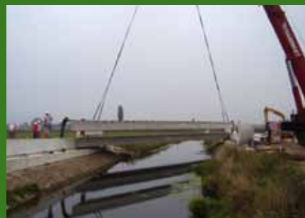
September 2008: de N837 kruist de Eldense Zeeg; met behulp van een hijskraan wordt de brug geplaatst.
